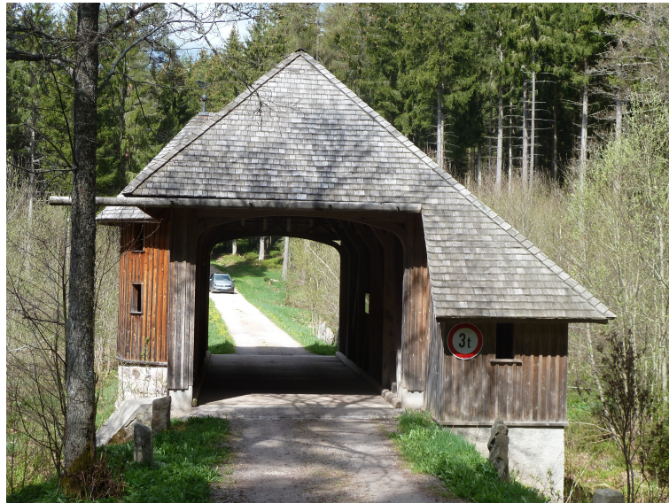
Kohlwaldbrücke über den Klausbach
