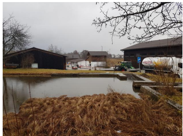
- Blick auf Auslaufbauwerk und Verlandungszone
