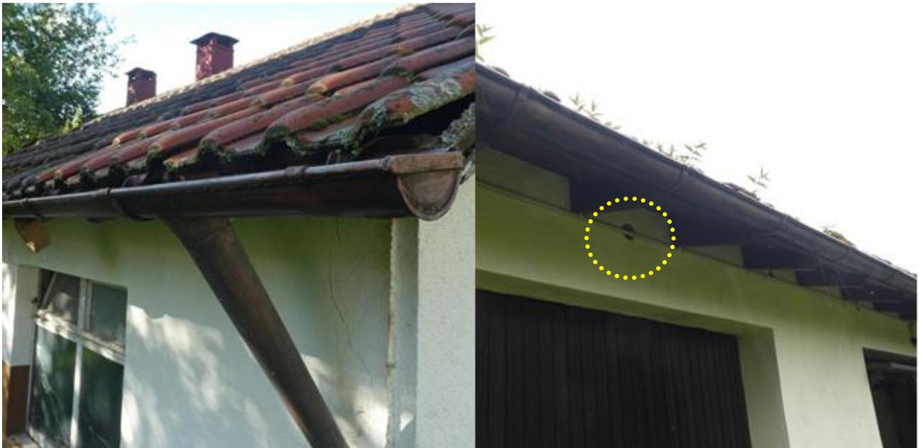
Abbildung 15: Linke Seite = Spaltenbereiche der Außenfassade; rechte Seite = runde Lüftungsöffnungen der Außenfassade, die in den Dachbereich führen. (Fotos: galaplan decker)
